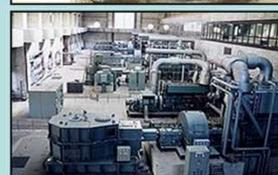
出水対応のために設置された河川用ポンプ及びゲート設備
