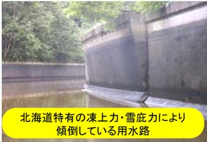
北海道特有の凍上力・雪庇力により傾倒している用水路
