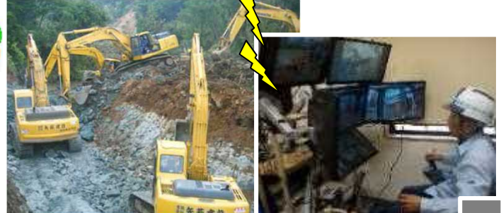
5G通信を活用した無人化施工のイメージ
