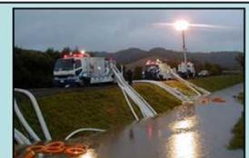
排水ポンプ車と照明車による排水作業
