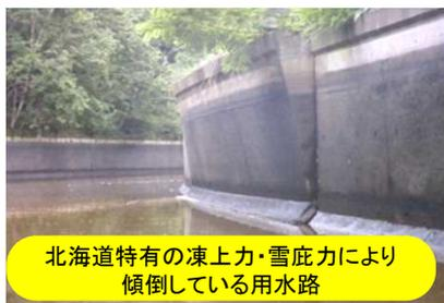
北海道特有の凍上力・雪庇力により傾倒している用水路
