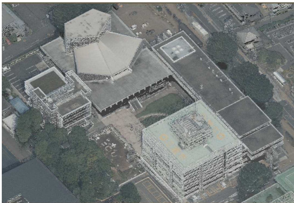
航空レーザにより建物モデルのレーザ点群を取得
