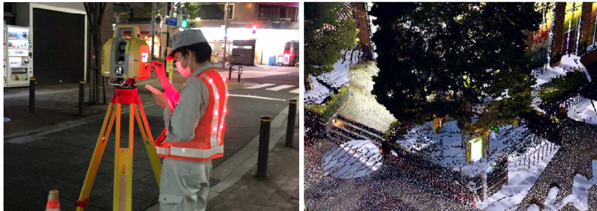
測量機器 により 点群取得
