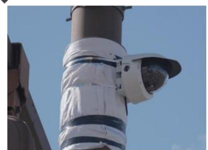
車両のカメラだけでは対向車の状況が把握しづらいため、路側にセンサー・カメラを設置して、遠隔管制室へ送信(通信は5G利用)
