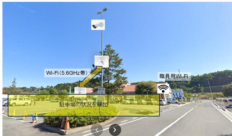
Wi-Fiでの画像伝送による駐車場の混雑可視化
