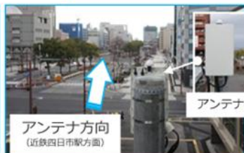
施工後（アンテナ拡大）
