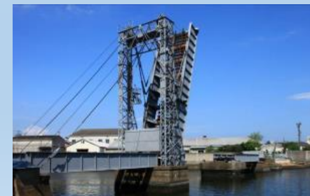
<末広橋梁（国指定重要文化財）> 現役最古の鉄道可動橋
