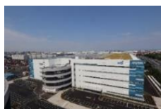
レールゲート （多目的倉庫）
