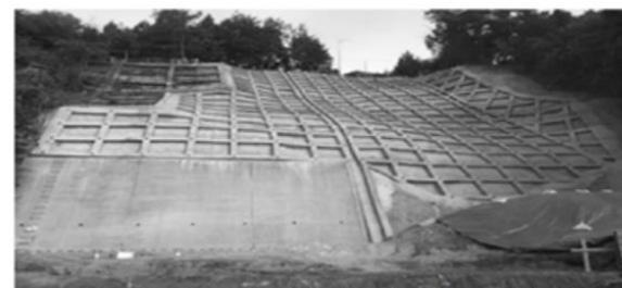
コンクリート枠による斜面の補強
