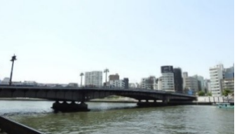
両国橋(88歳) 橋長 164.5m 架設 1932年(昭和7年) 管理 国土交通省 構造 3径間鋼ゲルバー桁橋
