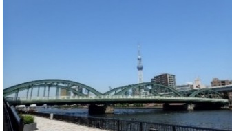
厩橋(91歳) 橋長 151.4m 架設 1929年(昭和4年) 管理 東京都 構造 下路式鋼タイドアーチ橋3連
