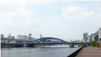
駒形橋(93歳) 橋長 146.3m 架設 1927年(昭和2年) 管理 東京都 構造 下路式鋼2ヒンジアーチ橋
