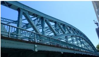
千住大橋(93歳) 橋長 91.7m 架設 1927年(昭和2年) 管理 国土交通省 構造 鋼タイドアーチ橋
