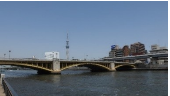
蔵前橋(93歳) 橋長 173.4m 架設 1927年(昭和2年) 管理 東京都 構造 上路式鋼2ヒンジアーチ橋3連
