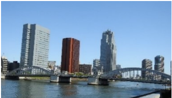
勝鬨橋(80歳) 橋長 246m 架設 1940年(昭和15年) 管理 東京都 構造 単純鋼タイドアーチ橋(側径間)シカゴ型双葉跳開橋(中央径間)
