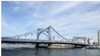
清洲橋(92歳) 橋長 186.2m 架設 1928年(昭和3年) 管理 東京都 構造 鋼自旋式チェーン吊橋
