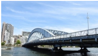
永代橋(94歳) 橋長 184.7m 架設 1926年(大正15年) 管理 東京都 構造 3径間鋼タイドアーチ橋
