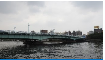
言問橋(93歳) 橋長 236.6m 架設 1927年(昭和2年) 管理 国土交通省 構造 3径間鋼ゲルバー桁橋
