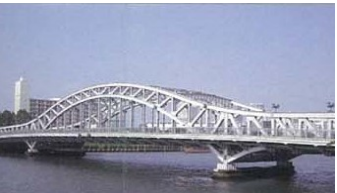
白髭橋(89歳) 橋長 168.8m 架設 1931年(昭和6年) 管理 東京都 構造 鋼バラストタイドアーチ橋
