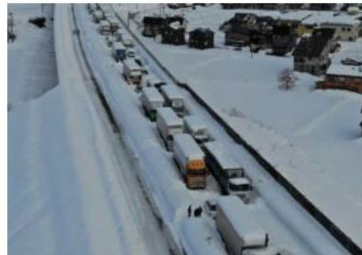
関越自動車道における大雪時の車両滞留の様子(令和2年末)
