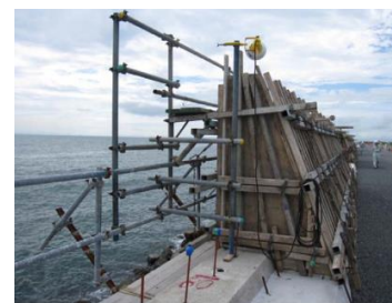
既存護岸の嵩上げ
