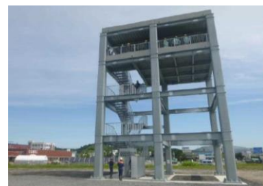
津波避難タワー(船川港)
