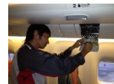
客室内の照明の交換
