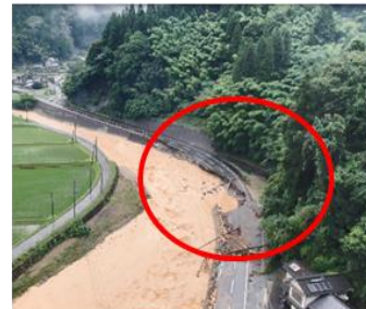
孤立地域内の道路崩壊を確認
