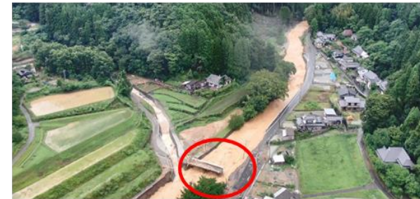
孤立地域内の橋の倒壊を確認 (孤立地域内の更なる孤立を把握)
