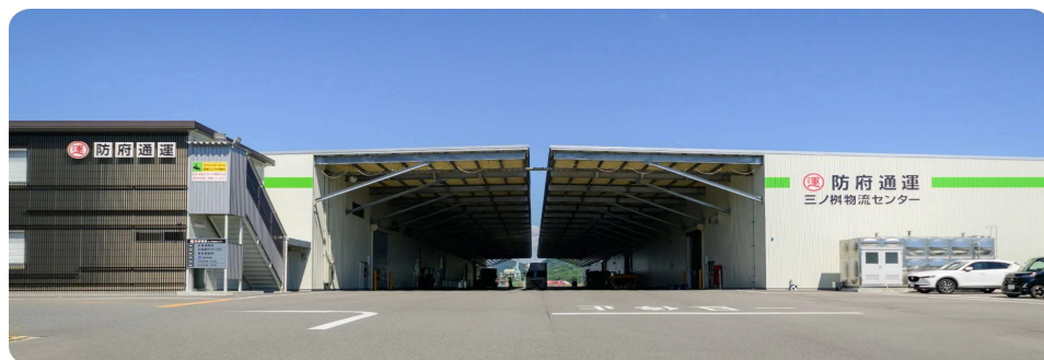
出典：防府通運(株)三ノ桝物流センター
