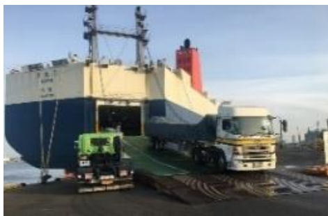
RORO船が着岸する岸壁
