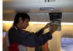
客室内の照明の交換
