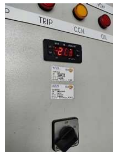
トラック庫内温度
