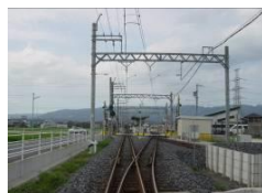
行き違い設備の新設
