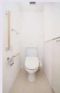
住戸内への 手すりの設置
