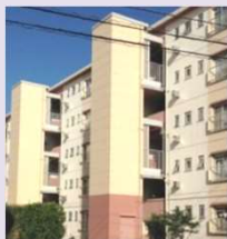
中層住棟への エレベーター設置
