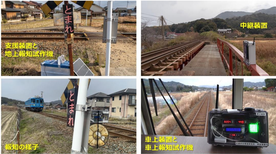
【図 3 第 4 種踏切での動作確認試験の様子】
