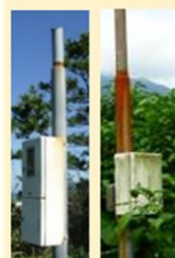
折損 腐食 鋼管柱(老朽化)
