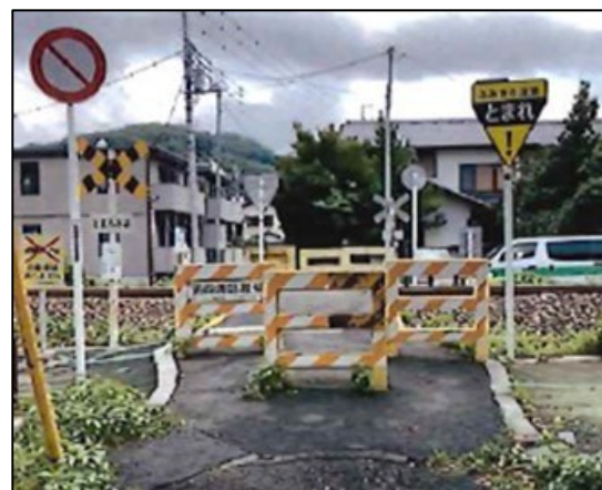
踏切道手前の柵の設置例
