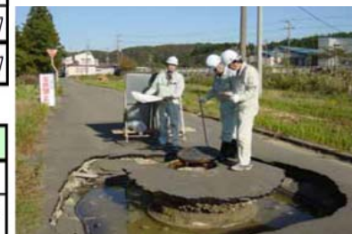
下水道の被害状況把握のための調査 (出雲崎町)
