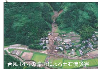
台風14号の豪雨による土石流災害 鹿児島県垂水市(平成17年9月)
