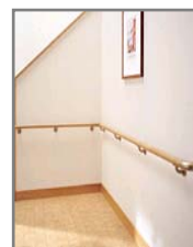
（手すりの設置）
