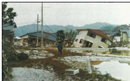
H16年 兵庫県豊岡市 (円山川の破堤による被害)
