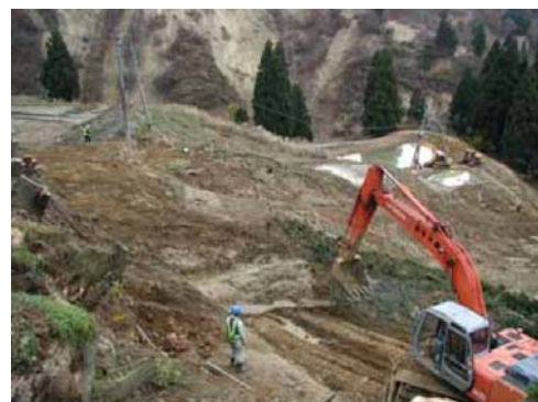
国道291号の復旧工事着手 (H16.11.11)
