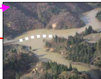
天然ダムにより水没した国道291号
