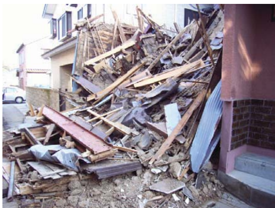
写真 5.3 鳳至地区で選択的に倒壊した家屋
