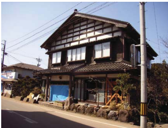
写真 5.23 被害は受けたが残留変形小の民家
