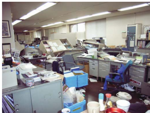
写真 6.4 室内のオフィス家具の転倒被害は大きい
