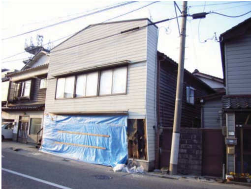
写真 8.2 K-net 輪島 周辺の建物被害
