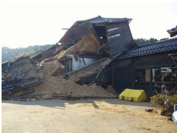
写真 5.1 倒壊したチップ工場
