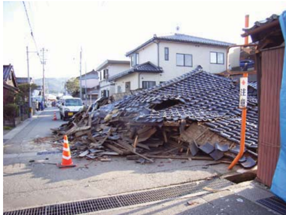
写真 5.8 道路をふさぐ倒壊例
