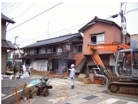
写真 5.41 残留変形が大きい店舗併用住宅
