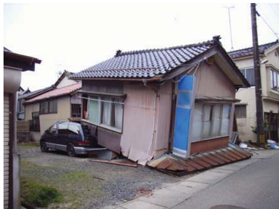
写真 5.40 倒壊し車両をつぶした家屋
