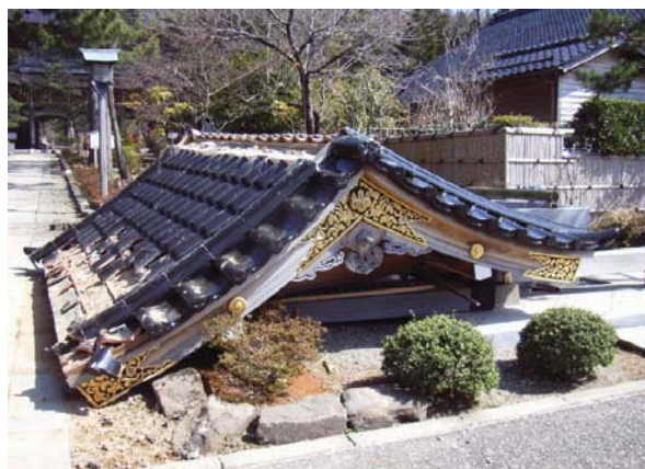
写真 5.18 倒壊した手洗い場の東屋
