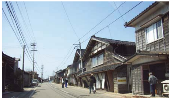
写真 5.30 道路側に大きく傾斜した家屋群
