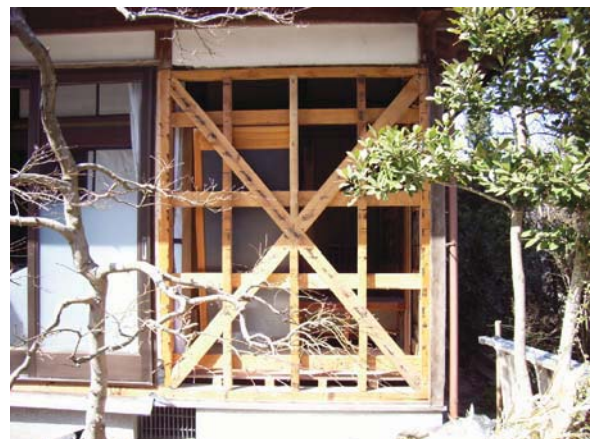
写真 5.24 左の民家の筋かい
