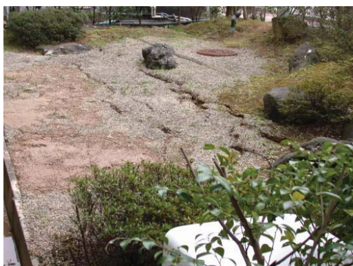
写真 8.8 震度計の周囲の地盤の液状化
