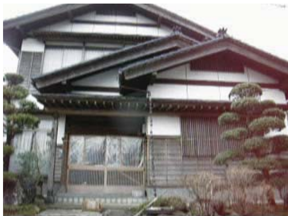
写真 5.43 外観上被害が軽微な建物
