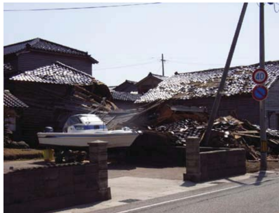
写真 5.34 倒壊した納屋又は倉庫
