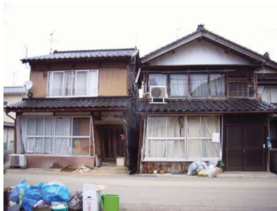
写真 5.44 衝突して外側へ傾いた建物
