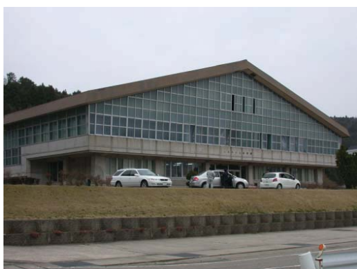
写真 6.13 七尾市中島体育館
