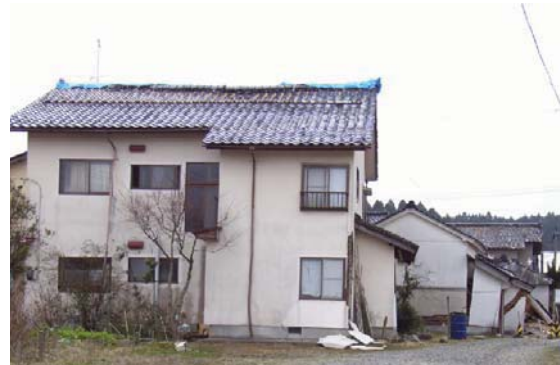
写真 5.36 商店街裏手の住宅
