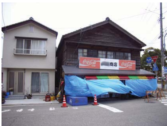
写真 5.39 倒壊した店舗
