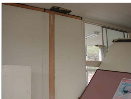
写真 7.7 間仕切り壁の接合部（固定冶具なし）
