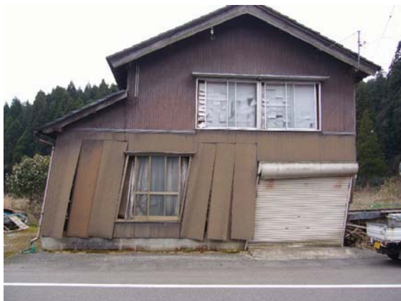
写真 5.47 残留変形が大きい車庫付き家屋
