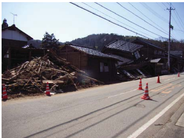
写真 5.13 倒壊家屋が建ち並ぶ門前地区
