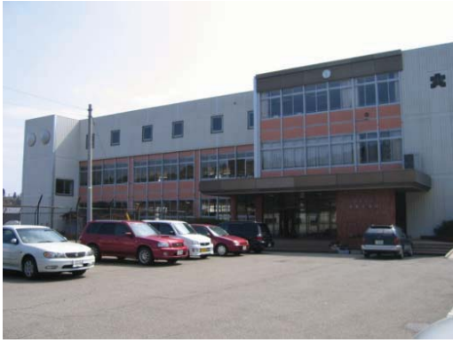
写真 7.1 大屋小学校（S 造 2 階建て）（軽微な被害）
