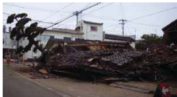
写真 5.14 樹木を倒して倒壊
