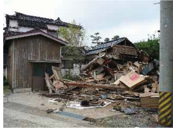
写真 5.34 車庫又は倉庫と推測される倒壊家屋
