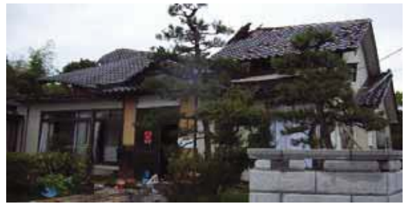
写真 5.4 小屋組の一部が崩壊する希有な被害例
