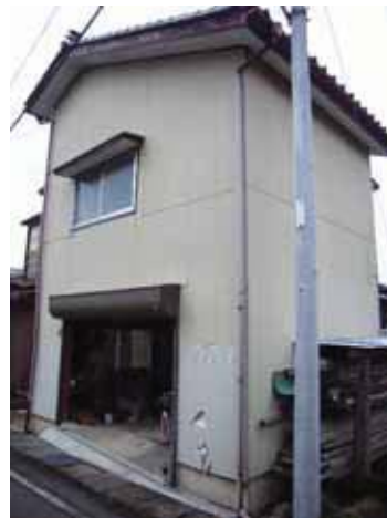
写真 5.6 外観上無被害の車庫
