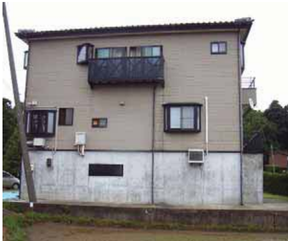
写真 5.5 ほぼ無被害の高床式住宅
