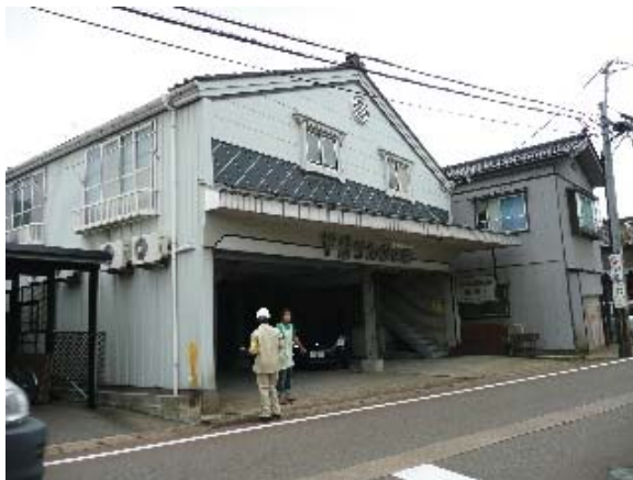
写真 5.35 1階に大きな車庫を取り、鉄骨と木造を併用した例
