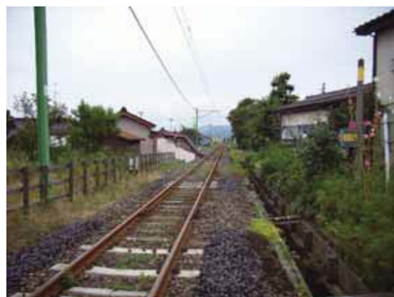
写真 5.10 線路に向かって倒壊した家屋
