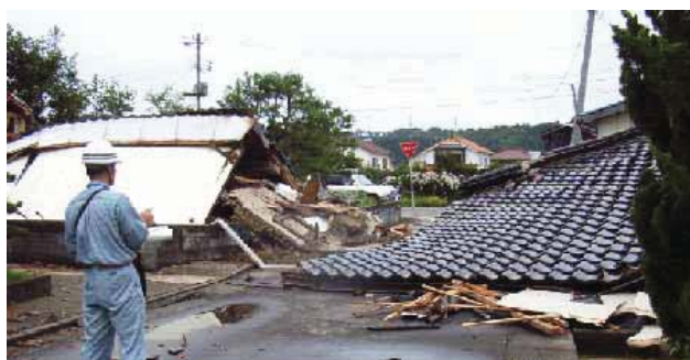
写真 5.1 倒壊して道路を塞いだ木造家屋
