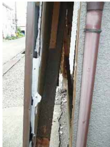
写真 5.36 開口脇の無開口壁に入る正角筋かい
