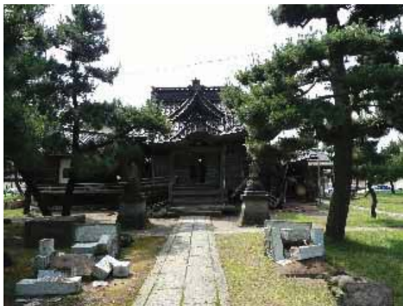
写真 5.32 壊滅的な被害を受けた新花町の金比羅宮
