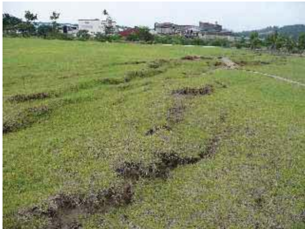
写真 5.43 鯖石川記念公園中央を貫くひび割れ
