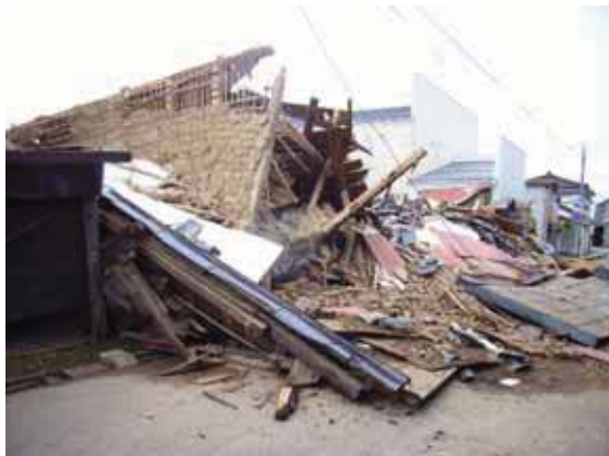
写真 5.15 土壁を有する古い構法の家屋
