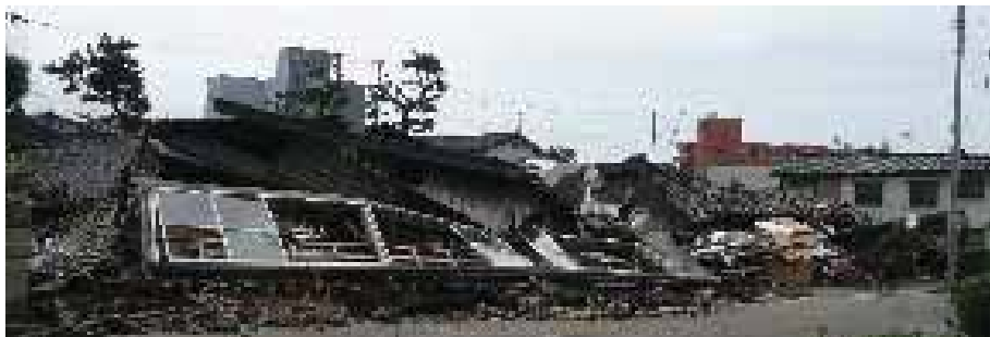
写真 5.27 倒壊家屋が連続する新花町
