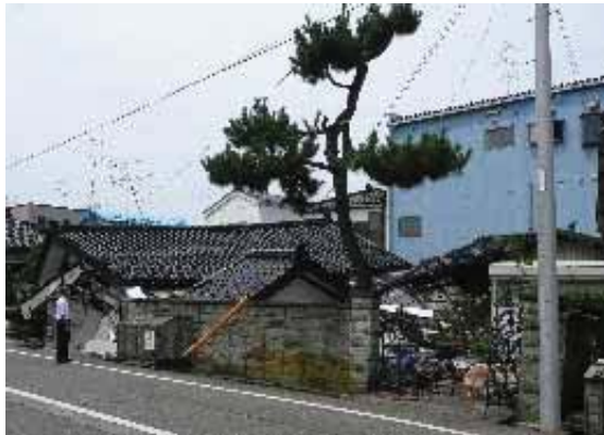
写真 5.30 一見新しい住宅に見える倒壊住宅
