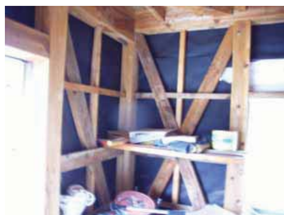
写真 5.8 写真 5.6 の筋かい
