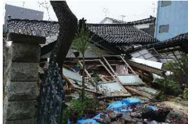
写真 5.31 写真 5.30 近景（土塗り壁の残骸が確認できる）
