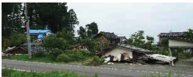
写真 5.17 多くの車庫、倉庫が倒壊
