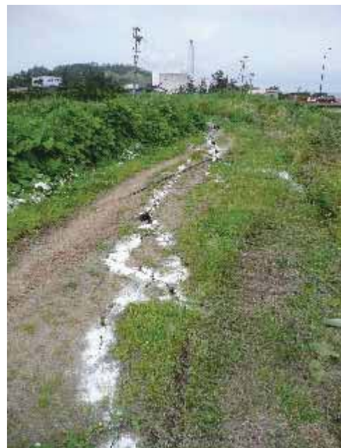
写真 5.46 ひび割れの進む方向にある 損傷したクリーンセンターの煙突
