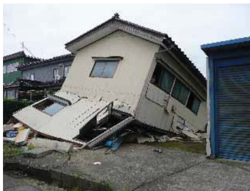
写真 5.18 倒壊した比較的新しい車庫兼作業所
