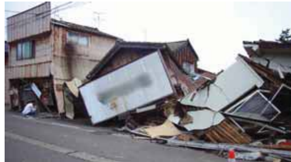
写真 5.12 倒壊した店舗併用住宅
