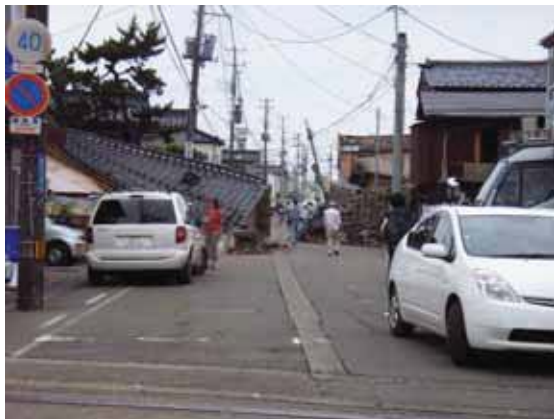
写真 5.9 東本町3丁目の倒壊家屋群
