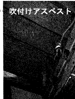
アスベスト含有 吹付けロックウール
