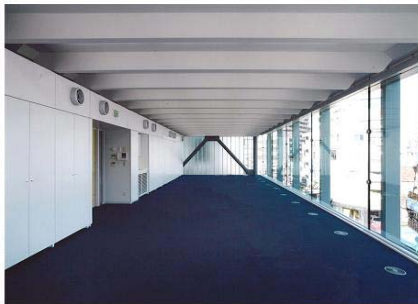
Kビル：SRC／S造、PC床板、地上6階、延床930m 2 、階高3050mm、複層ガラス
