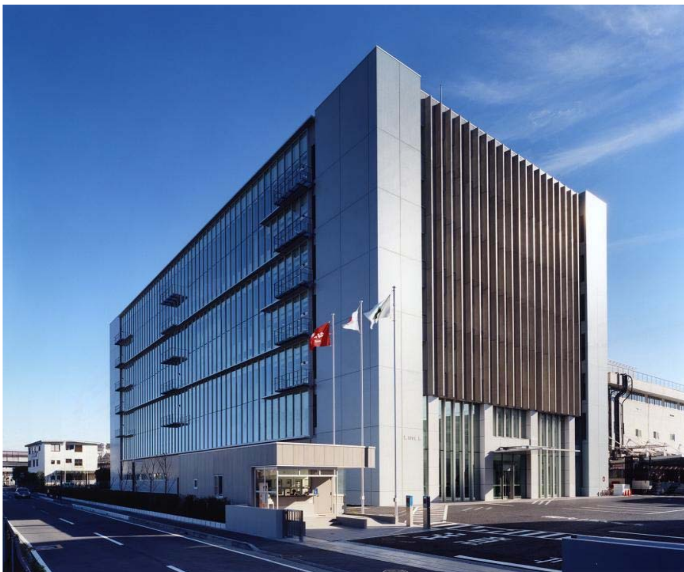
Yビル：S造・RC造、地上7階、延床18,000m 2 、CASBEE評定 ランクS
