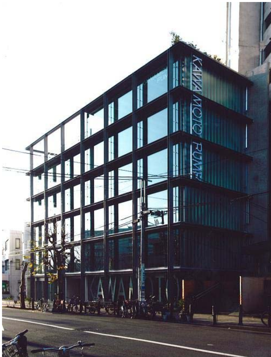
Kビル：SRC／S造、PC床板、地上6階、延床930m 2 、階高3050mm、複層ガラス
