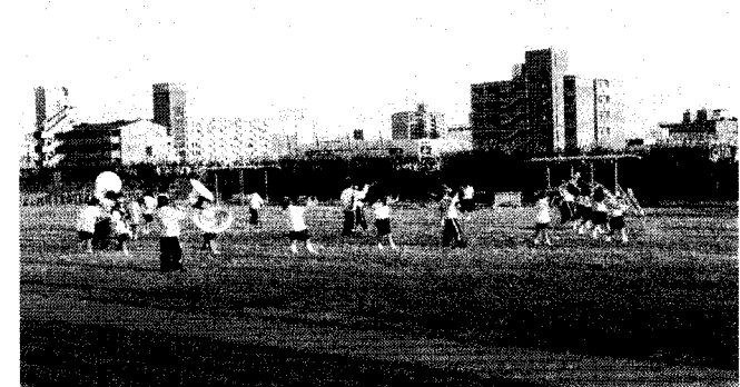
下水処理場の上部を利用した公園整備(大阪市)
