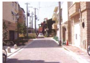
拡幅された道路
