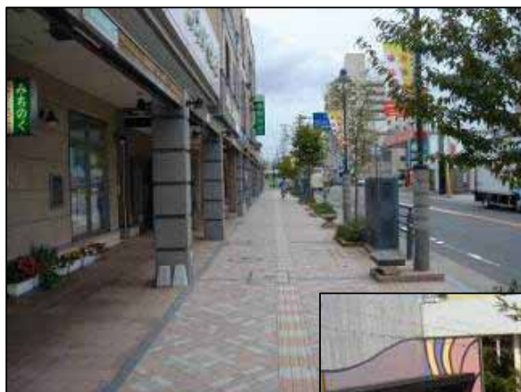
一階部分をセットバックした歩行空間（弘前市）
