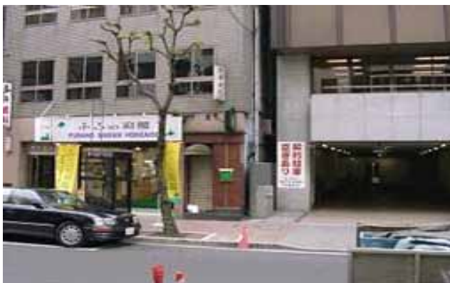
・メインストリートに面する駐車場が街並み分断、歩行環境悪化を招いている
