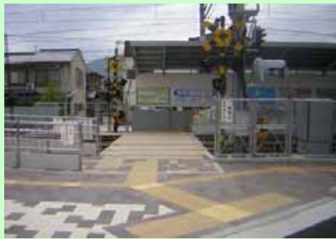
駅構内通路 (上下線の移動を円滑化)
