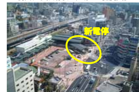
【横川駅前広場整備後】
