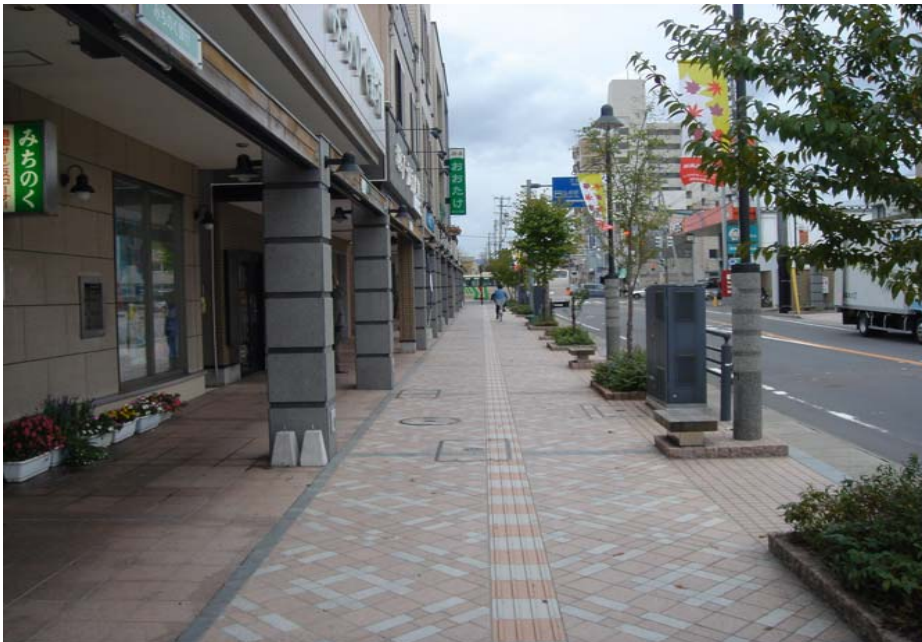
一階部分をセットバックした歩行空間（弘前市）
