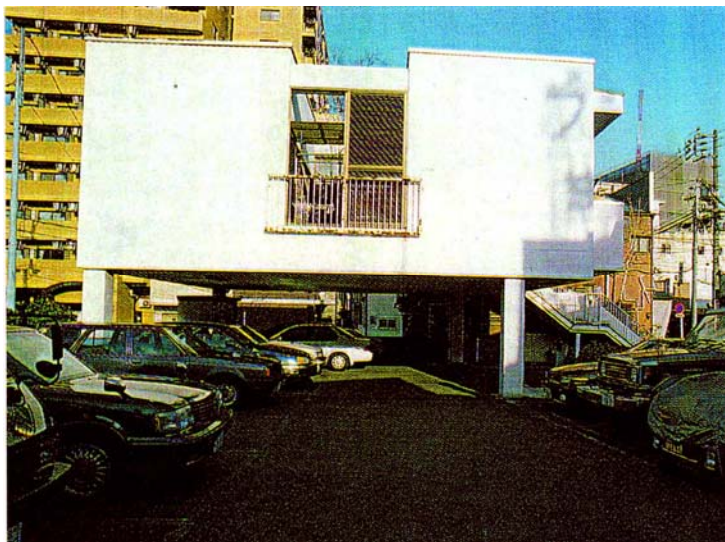
ピロティー建築による耐水化
