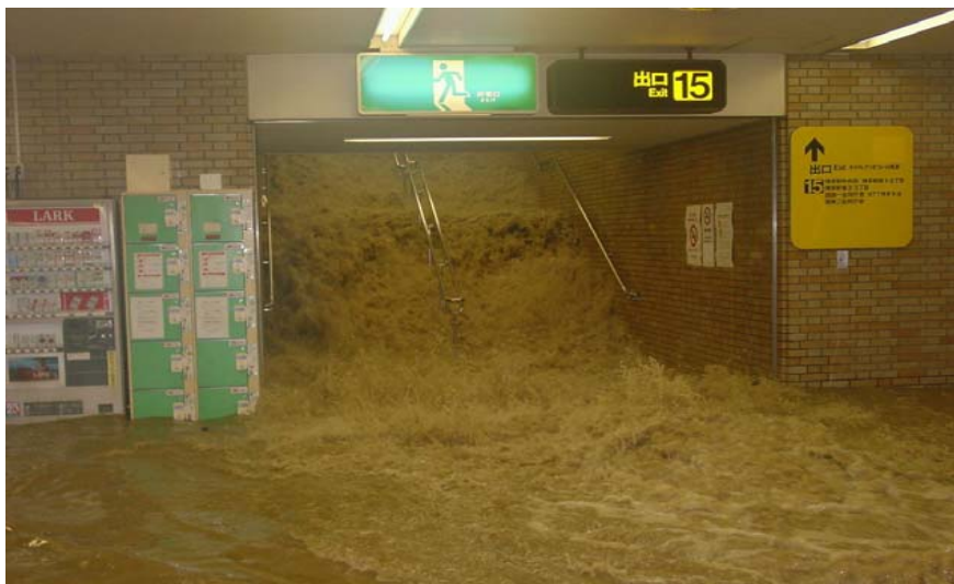
地下街への浸水の様子 (平成15年福岡市)
