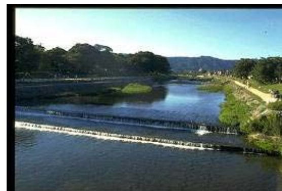
鴨川周辺地区 (京都市左京区) 出典:京都市HP
