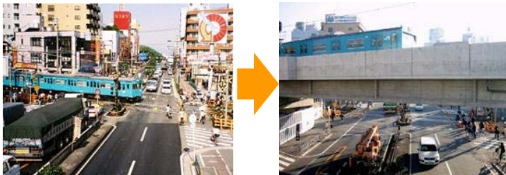
整備前後でのJR阪和線(長居南1踏切)の状況
