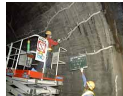
ひび割れの補修
