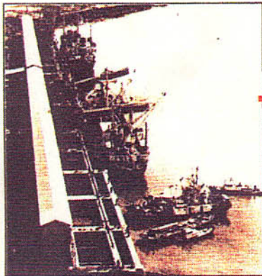
北海道産石炭積出岸壁
