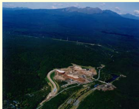
砂防事業（樽前山錦多峰2号遊砂地）
