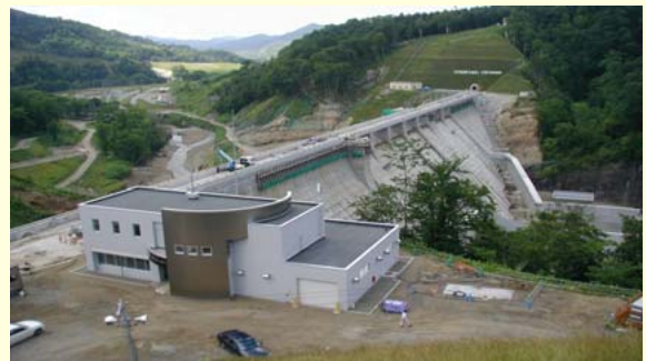
ダム事業（庶路ダム）
