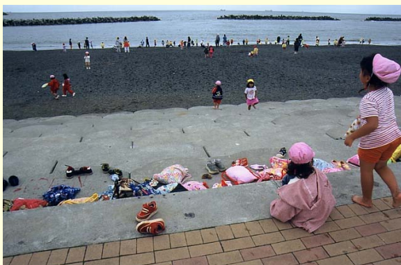
海岸事業（苫小牧港海岸（汐見地区護岸））
