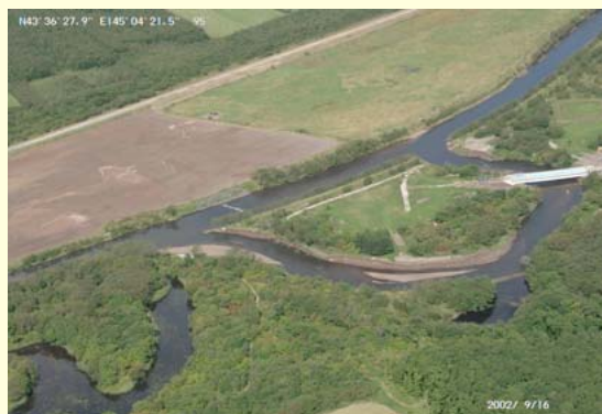
河川沿いの良好な水辺林の保全・再生 (標津川蛇行復元)
