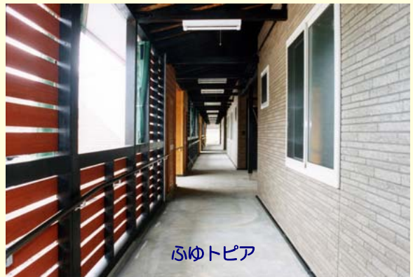
冬の住生活に配慮した公営住宅 （冬でも安全で快適な歩行空間の設置）
