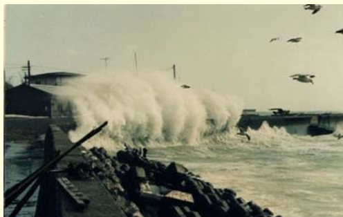
えりも港海岸（本港地区） 高潮状況
