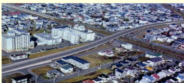
鉄道との立体交差事業 (西宮の沢・新発寒通：イメージ図)
