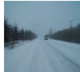
防雪林設置後
