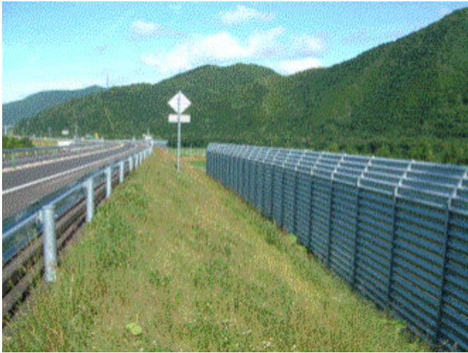
図．高盛土への防雪柵の設置事例
