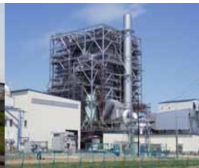
廃プラスチック火力発電所 (苫東)
