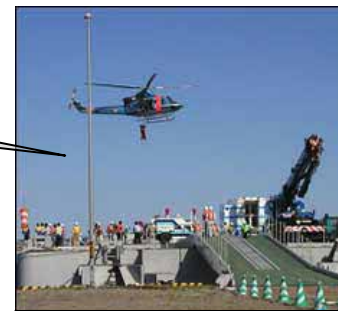
防災フロート上での道警ヘリコプターによる救急患者の吊り上げ作業
