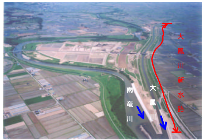
大鳳川新水路
