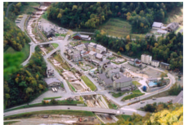
黒岳沢川床固工群(2001年完成予定)と 層雲峡温泉街 - 石狩川上流直轄砂防事業 -
