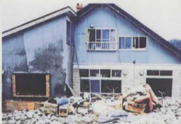
昭和56年8月豪雨による土砂災害(札幌市)
