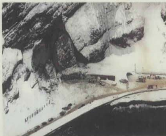
豊浜トンネル崩落事故
