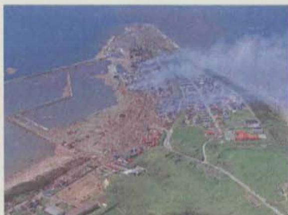
平成5年北海道南西沖地震津波被害(奥尻町)
