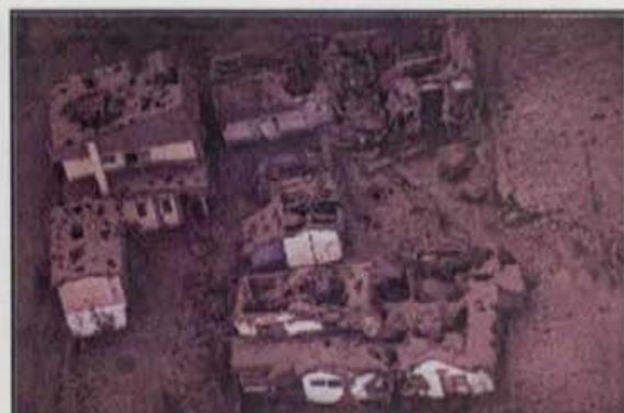
金比羅山火口付近住宅被害状況(2000年5月撮影)
