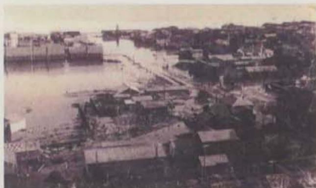
チリ地震津波による被害（浜中町）
