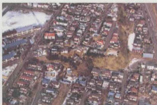
平成5年1月釧路沖地震による土砂災害(釧路市)
