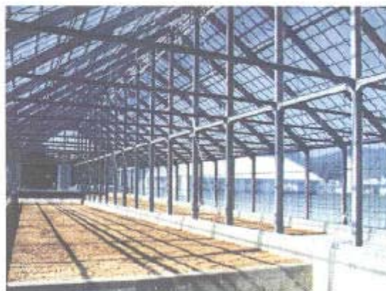
家畜排せつ物の適切な処理のための堆肥舎
