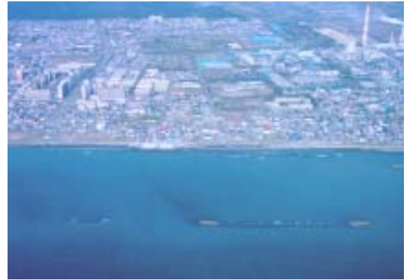
直轄胆振海岸保全施設整備事業 - 人工リーフ整備の推進 -
