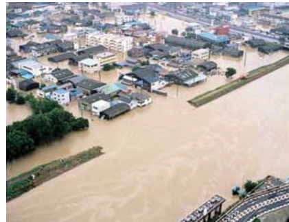
東海水害(2000.9)新川破堤状況
