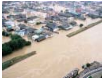
東海水害(2000.9)新川破堤状況
