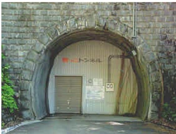
新山伏トンネルの完成によって役目を終えた旧山伏トンネルが、雪を利用しての農産物貯蔵施設として平成13年に生まれ変わりました。今まで厄介者であった雪と夏期の冷涼な気象条件、使用されなくなった旧山伏トンネルの断熱性の高い環境を活用し、雪を冷熱源とする低温貯蔵施設にトンネル内部を改造し、地元農産物の低コストでの長期貯蔵を実現するものです。
