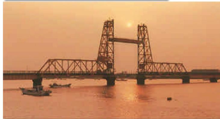
佐賀県諸富町と福岡県大川市の間を流れる筑後川に架かる昇開橋は、昭和10年5月に旧国鉄佐賀線の鉄橋として開通した我が国最大級の鉄道用可動橋である。この可動橋は、全長506m、中心部が高さ30mの二つの鉄塔に沿って23mの高さまでエレベーターのように昇り、開通当時は東洋一の昇開橋だった。しかし、昭和62年3月、佐賀線の廃止とともに鉄道としての役目を静かに終え、現在は、遊歩道の一部として再び活用されている。
