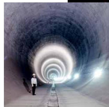
46 環状七号線地下調節池の内部
