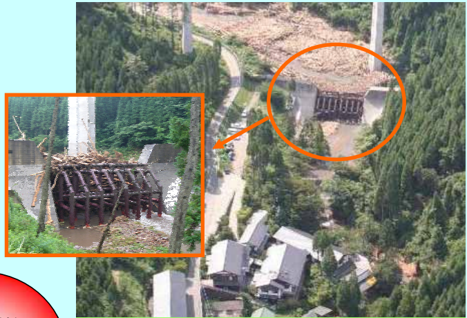
施設整備により、災害時要援護者関連施設や避難所の保全を重点的に実施。
