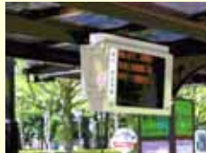
バスロケーションシステム
